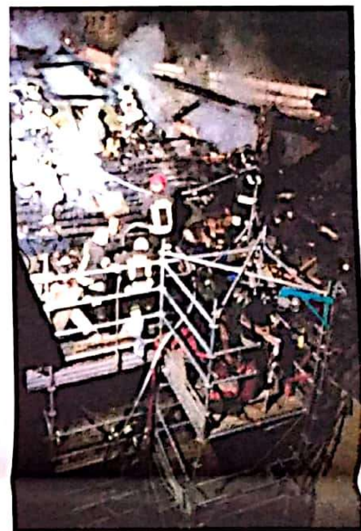
La lingua di fuoco sulla Sacra vista dal fondovalle (foto Enrico Pollone) e, sopra, un particolare del tetto che brucia; a lato, i vigili del fuoco al lavoro tra le impalcature; in basso, le alte fiamme divampate sopra il convento antico (foto Roland Crosazzo)
